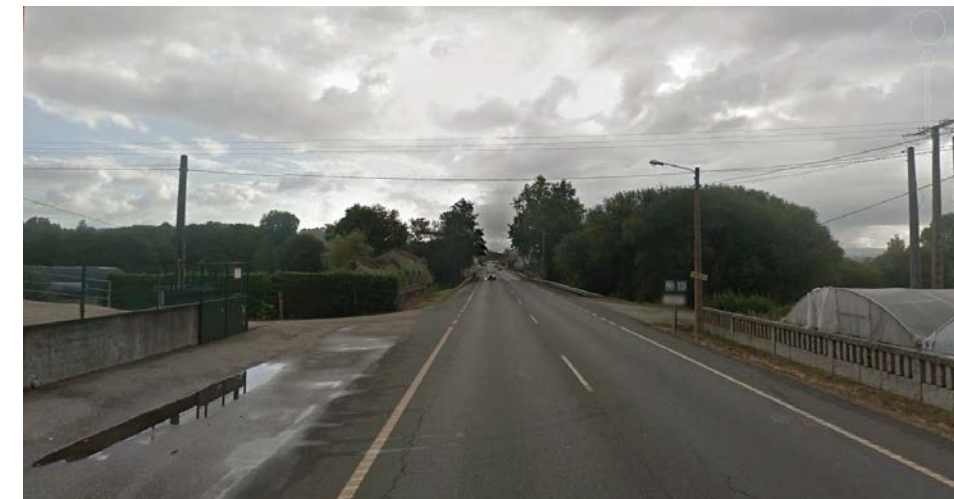
Vista general de la intersección
