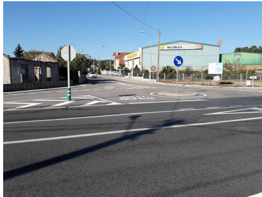
Intersección del P.K. 60+600 con la PO-344
