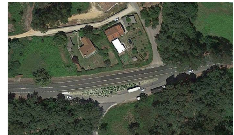
Vista aérea de los accesos en el entorno del pk 61+440
