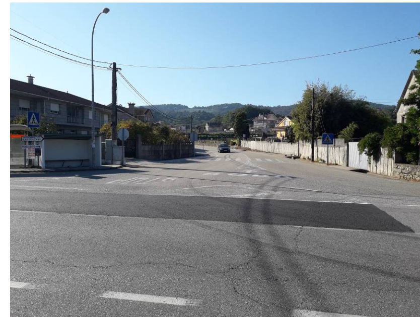
Intersección 71+000 con PO-350
